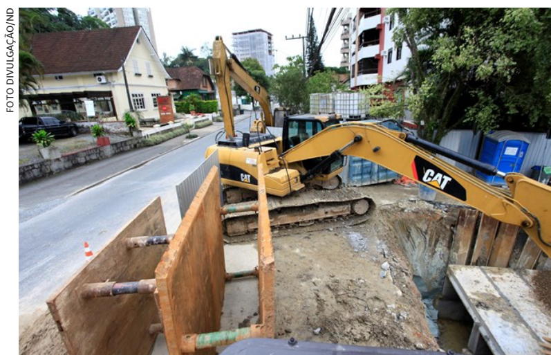
Obras do rio começaram em 2014 e eram tidas como a principal solução para conter os alagamentos frequentes que ocorrem no Centro de Joinville
