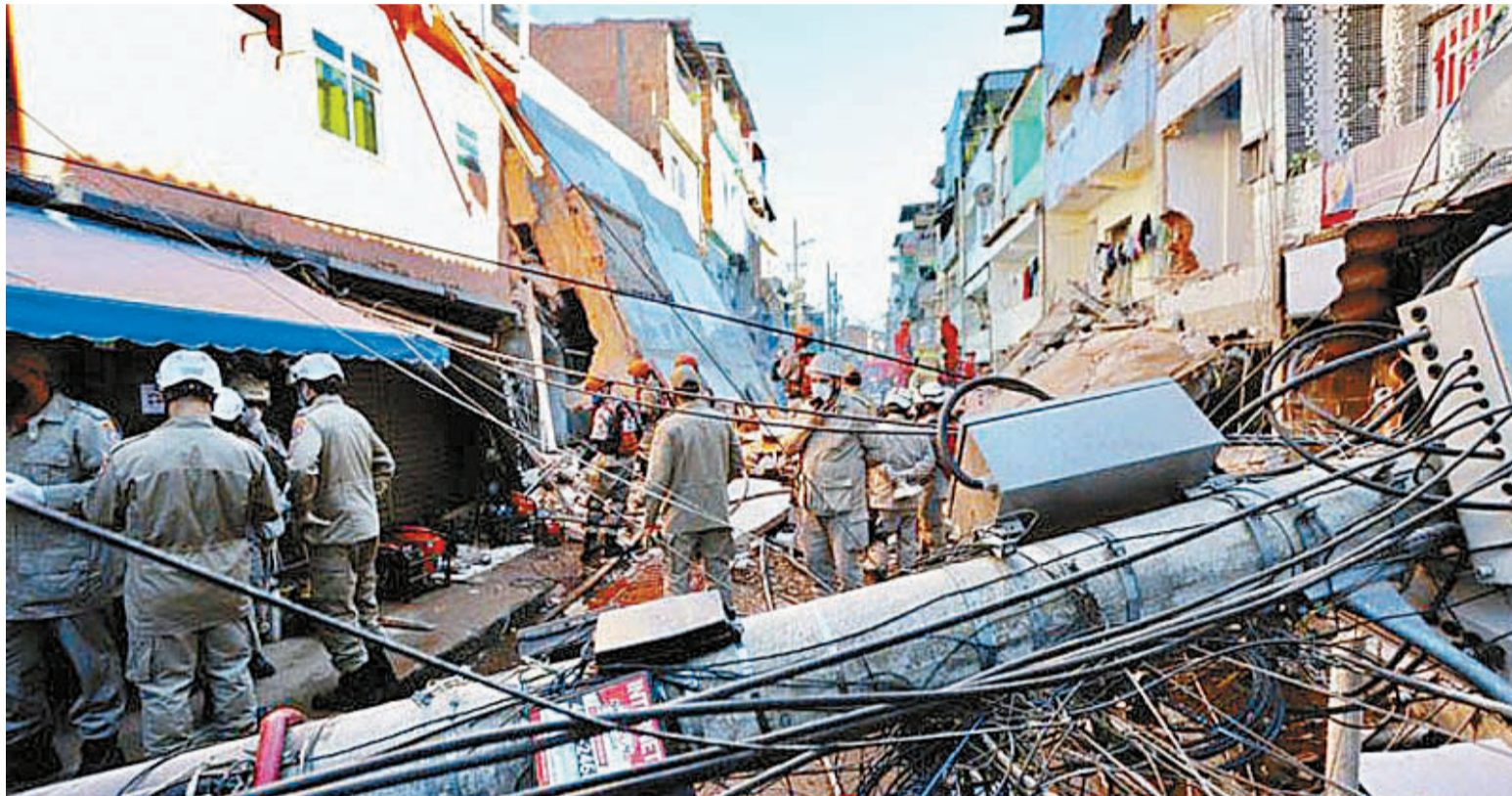
A construção irregular com quatro andares, em Rio das Pedras, desmoronou na madrugada de ontem e matou duas pessoas
