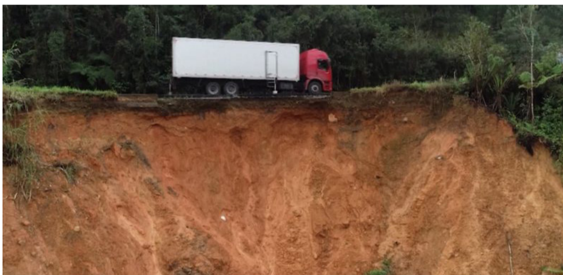
Localizado no km 27 da SC-418, o trecho que sofreu a erosão está com o tráfego liberado em apenas uma das faixas
