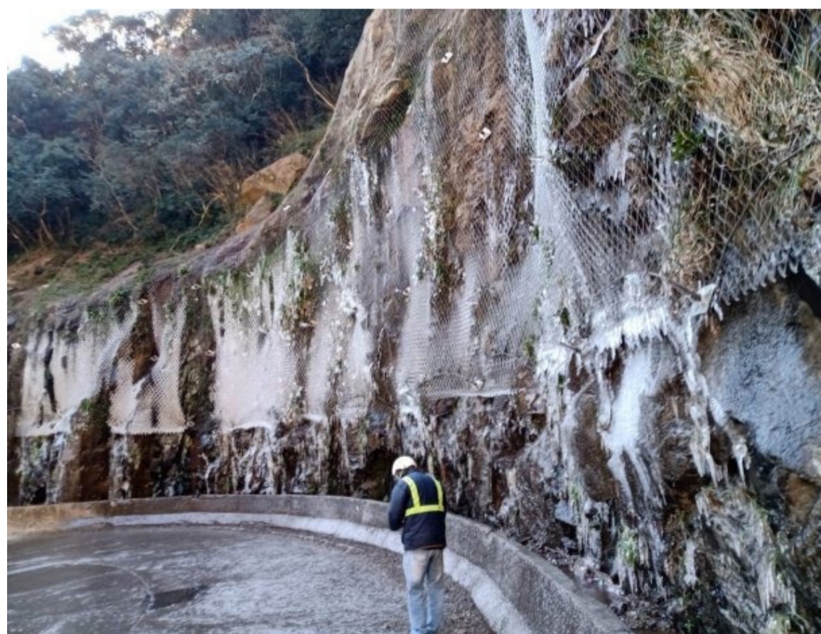
Com a pista em obras e camada de gelo sobre o asfalto, tráfego de veículos foi totalmente bloqueado na rodovia
