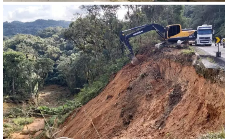
Máquinas da empresa contratada chegaram ontem ao local e iniciaram os trabalhos para a recuperação da encosta com talude rochoso
