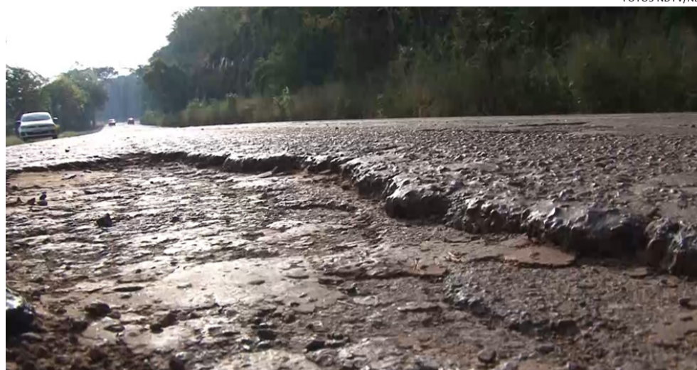
Comunidade pede manutenção para a SC-163 e também a federalização da via
