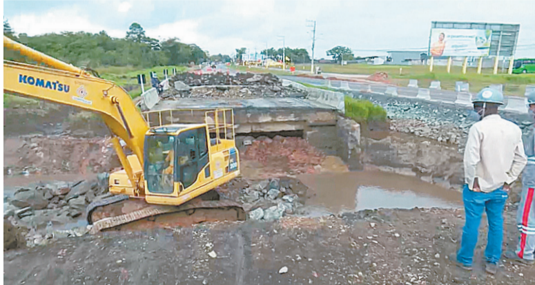
Ritmo é lento dos trabalhos executados na rodovia federal
