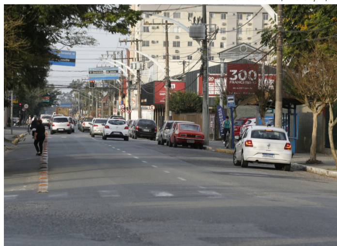
Recuperação asfáltica da via será feita entre a Avenida Getúlio Vargas e a BR-101
