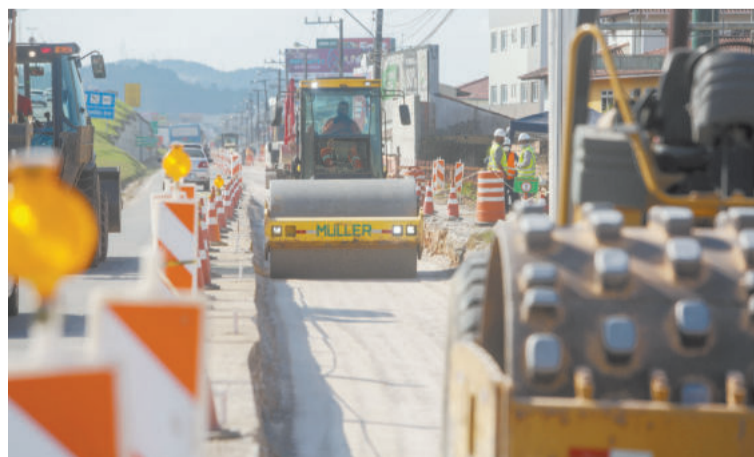
Obras da terceira faixa pista norte da BR-101 têm previsão de conclusão para novembro
