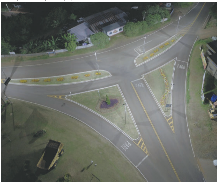
Em Itá, o município instalou lâmpadas com a tecnologia LED em toda a iluminação pública e placas fotovoltaicas nos seus prédios
