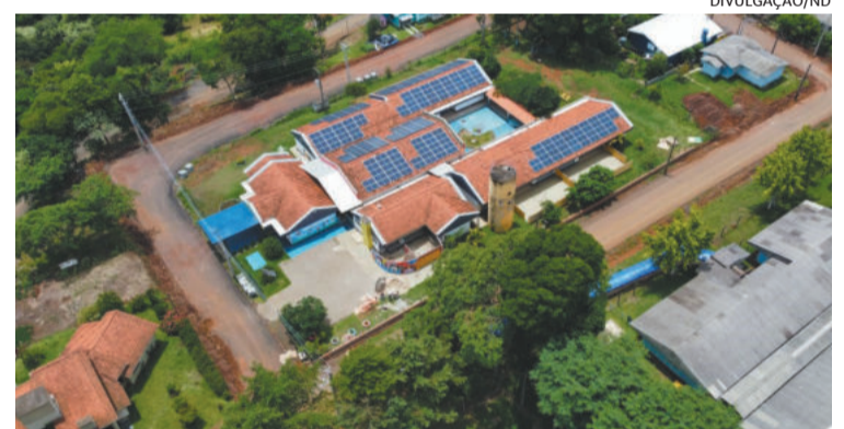
Com a adoção de LED e fotovoltaica Itá economizará cerca de R$145 mil por ano nas faturas de energia elétrica
